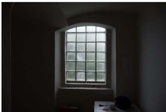
Okno zasklené luxfery
