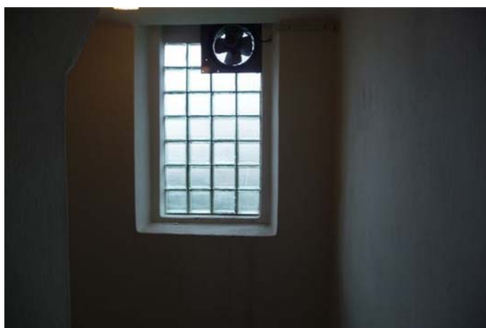
Okno zasklené luxfery s ventilátorem
