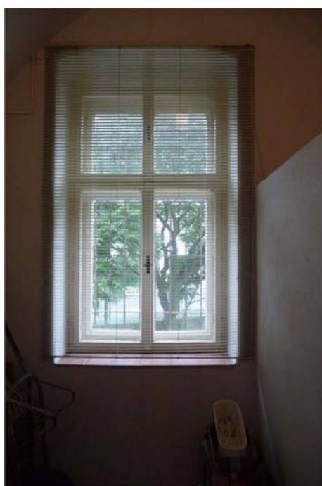
Pohled na okno zevnitř
